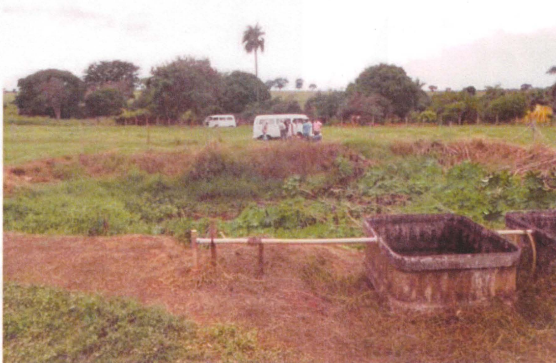
Figura 7 - Reservatório 01, fonte da contaminação estudada.
